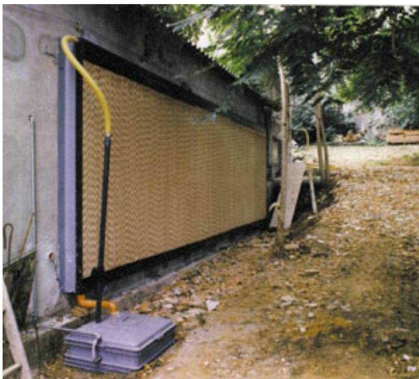
Рисунок 3. Охлаждающая панель
